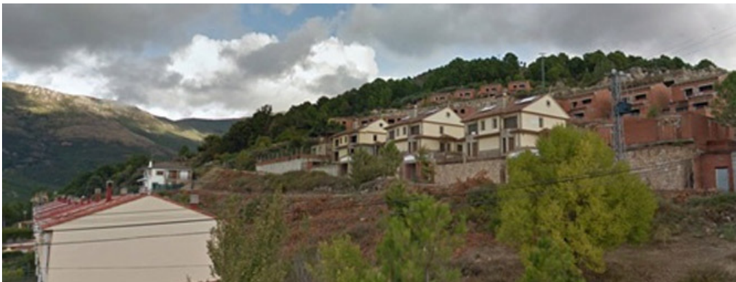
Viviendas sin terminar de la urbanización afectada en Pedro Bernardo.
