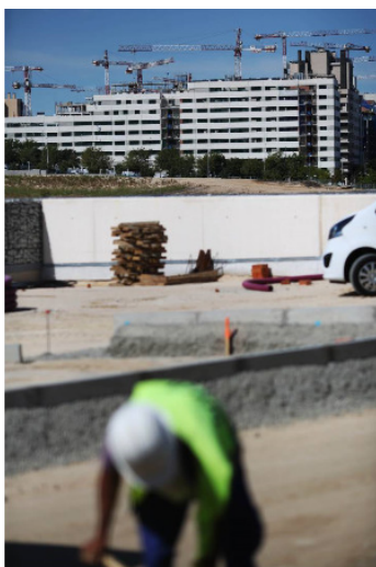
Construcción de viviendas en Valdebebas (Madrid). ALVARO GARCÍA
